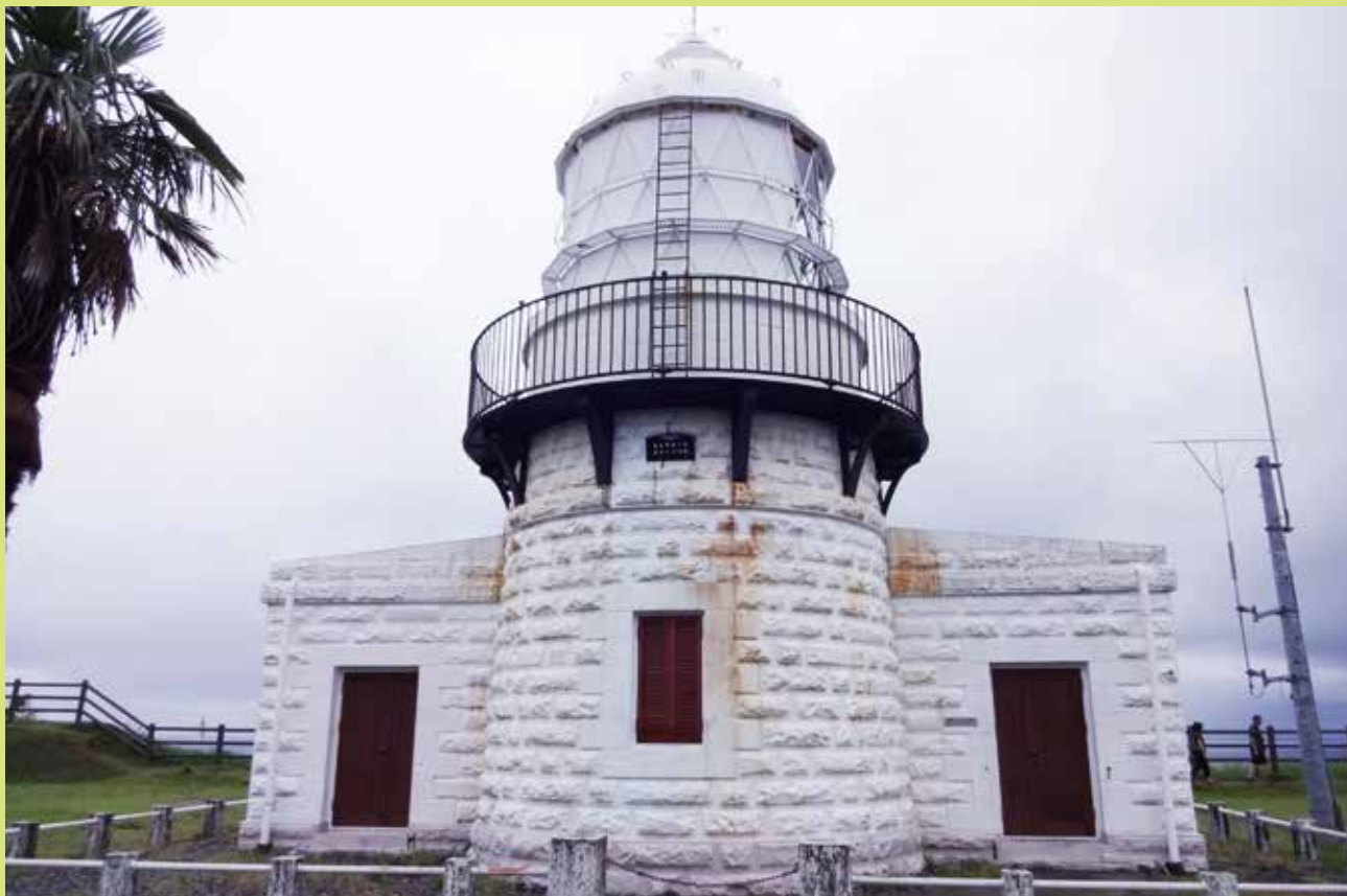
禄剛埼灯台(ろっこうさき・石川県珠洲市)
