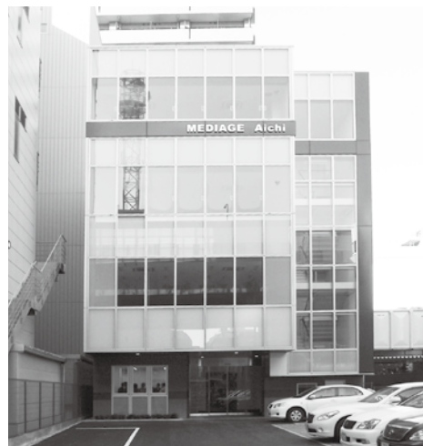
国道41号線沿いで、地下鉄や名古屋高速の利用も大変便利。ガラスカーテンウォールのお洒落でコンパクトなオフィスビルです。
